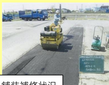
舗装補修状況
