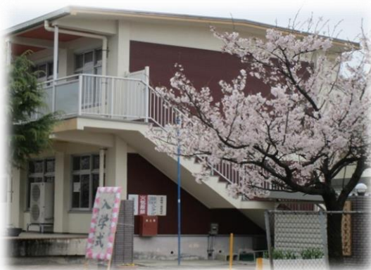
寺家小学校管理棟 ▶
