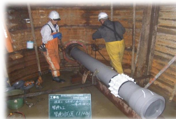
▲公共下水道管渠埋設工事
