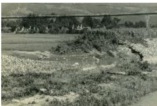
決壊した堀江の堤防 / 滑川市立博物館 1969（昭和 44）年
