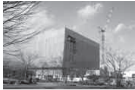
6月のオープンを目指して建設中の滑川市民交流プラザ
