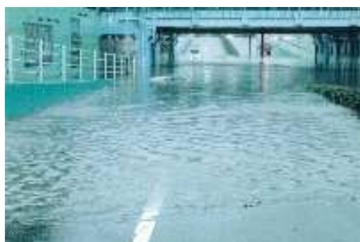
浸水した市道のアンダーパス 2001(平成13)年
