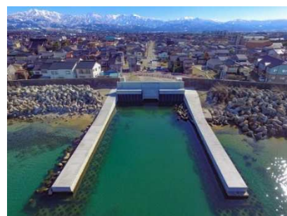
海側から見た沖田川放水路（第 1 期） 2017（平成 29）年
