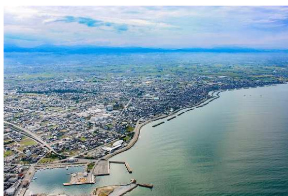
離岸堤が並ぶ沿岸部西側
