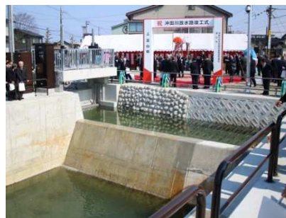
完成した沖田川放水路（第 1 期） 2017（平成 29）年
