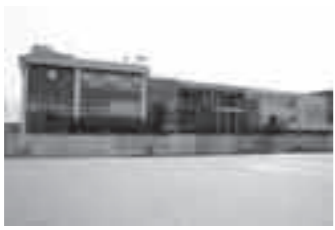
耐震補強および大規模改造工事中の西部小学校
