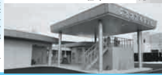
完成したアクアポケット(滑川市坪川新地内)
