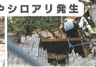
雨漏り発見の遅れによる 建物の腐食やシロアリ発生
