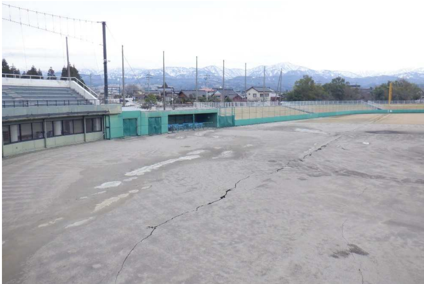
令和6年能登半島地震における地割れ
