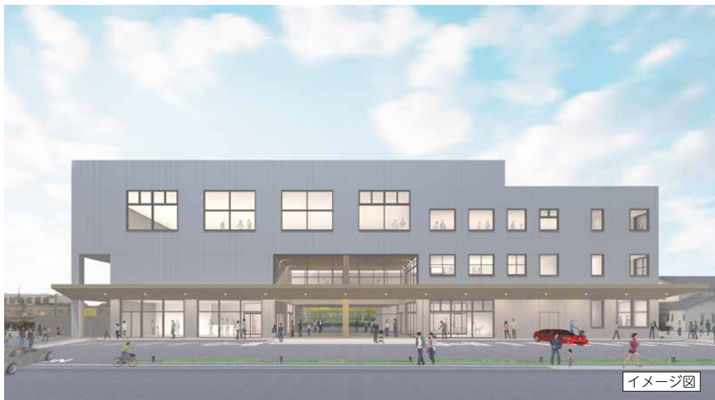
中滑川駅防災・賑わい施設
