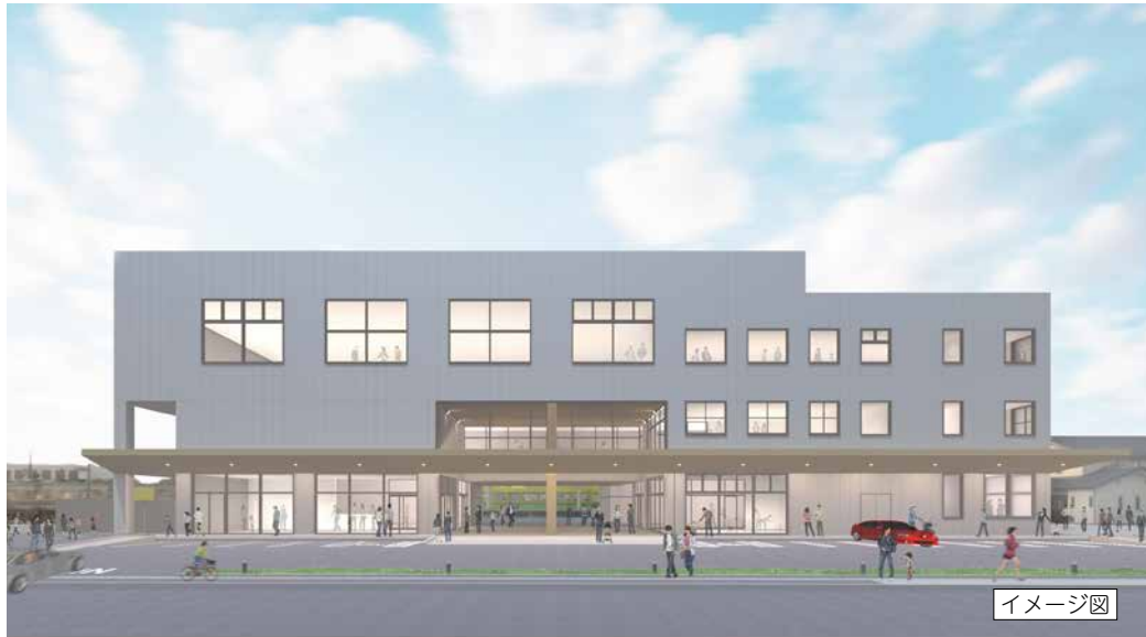
中滑川駅防災・賑わい施設
