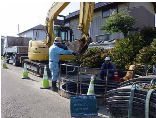
下水道敷設工事
