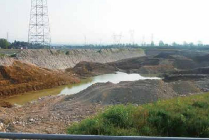
掘削深が地下水脈まで達し、地下水が溢れ出した事例も
