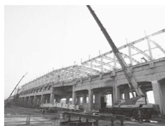
▲駅舎の建設に使用される鉄骨
