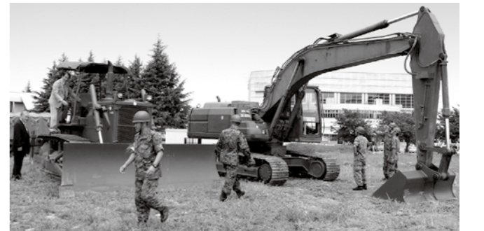
▲起工式の後、重機や工事予定地を見て回る市長と陸上自衛隊員ら
