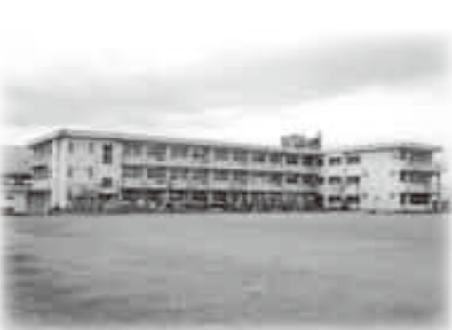
耐震補強と大規模改造工事を行う南部小学校
