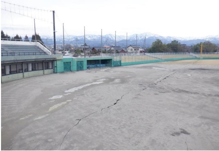
令和6年能登半島地震における地割れ
