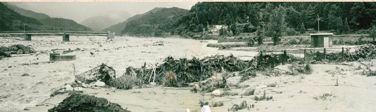
入会橋付近(下流側から近景)／昭和44年(1969)／館蔵
