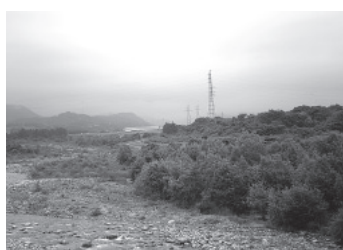
整備が待たれる低水護岸(大島地先)
