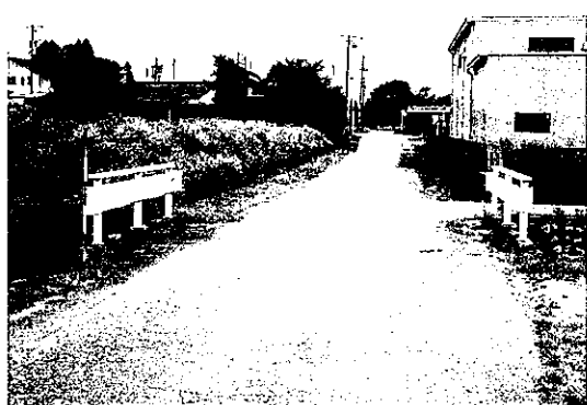
大崎野川橋梁補修
