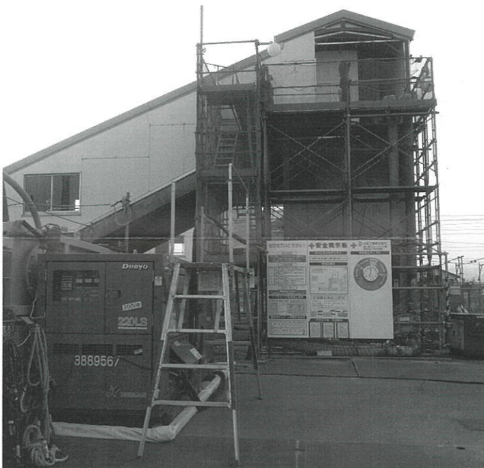
工事現場の写真
