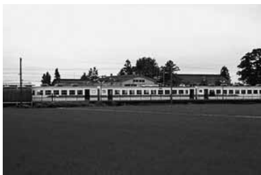
山側から見た東滑川駅
