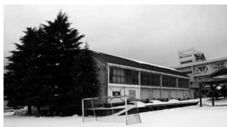
耐震化が決定した東部小学校多目的ホール
