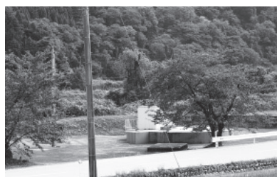
上大浦地区第一水源井戸周辺
