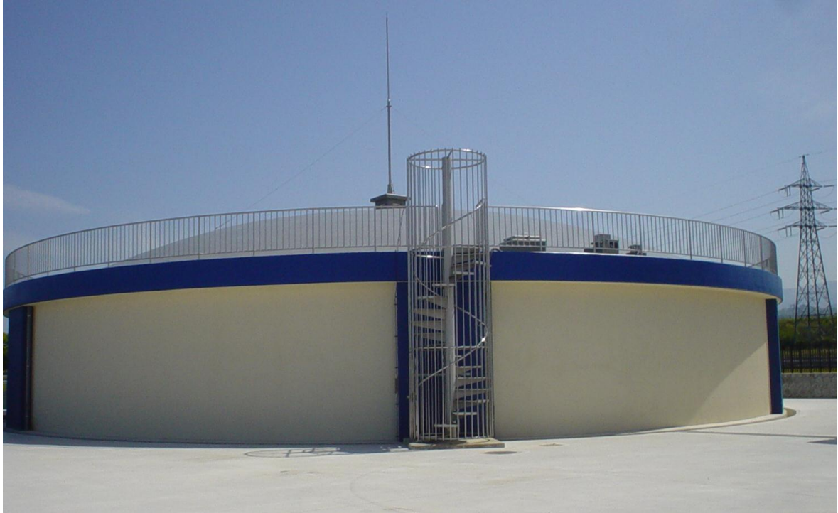
(新横道配水池 平成21年完成)
