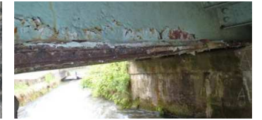
鋼材の腐食
