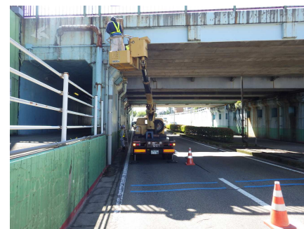
(橋梁下面の点検状況)
